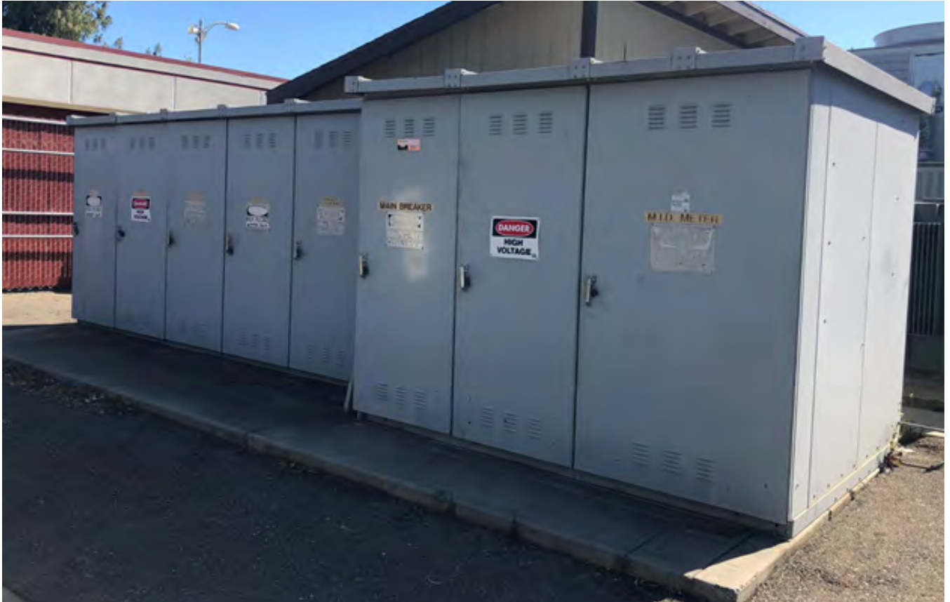
12KV SWITCHGEAR
